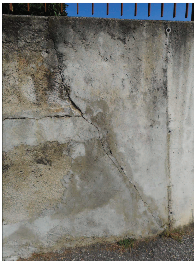
FIG. 38 Lesione su muri di proprietà esistenti
