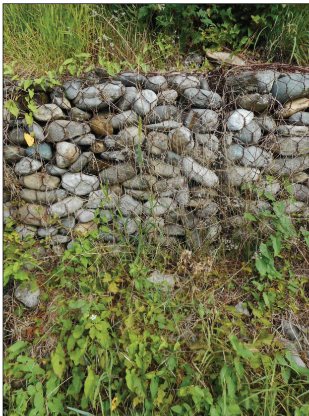
FIG. 31 Gabbionate esistente da demolire
