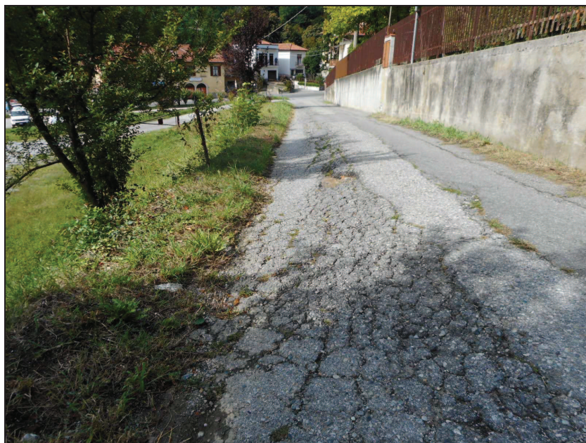
FIG. 33 Cedimento lungo il bordo esterno carreggiata esistente
