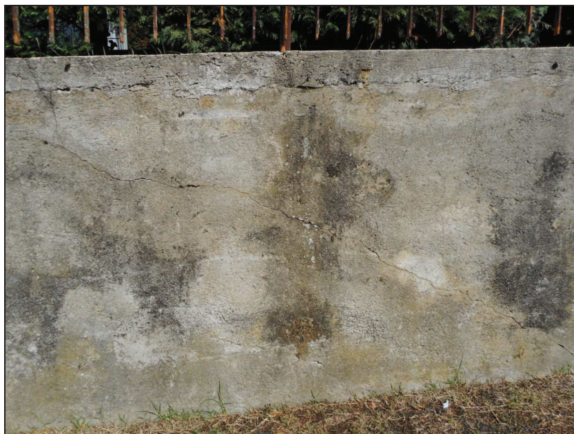
FIG. 37 Lesione su muri di proprietà esistenti
