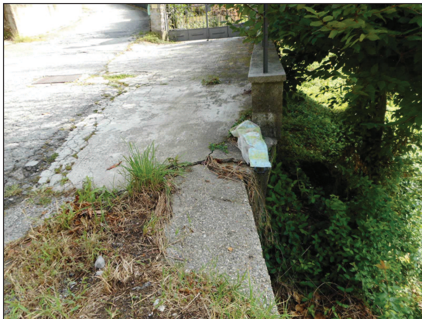
FIG. 35 Lesione su muri di proprietà esistenti
