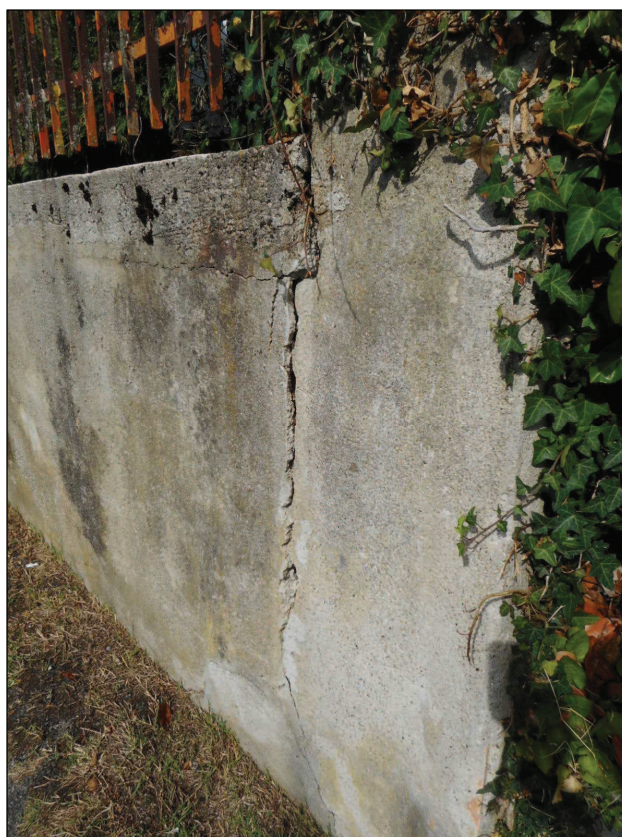
FIG. 36 Lesione su muri di proprietà esistenti
