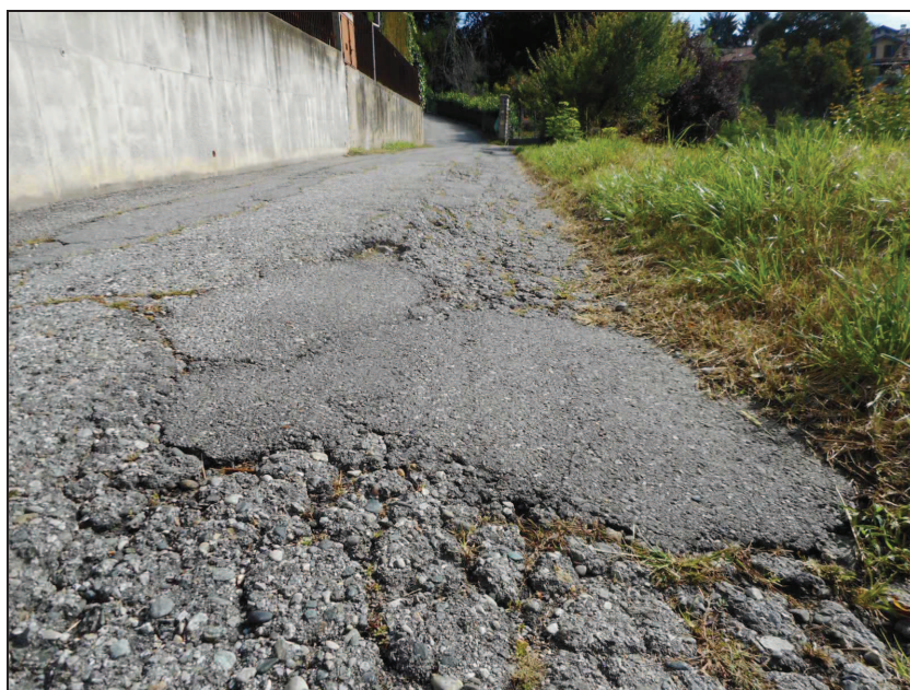
FIG. 32 Cedimento lungo il bordo esterno carreggiata esistente
